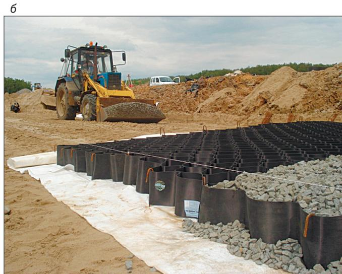
Рис. 2. Укрепление основания автомобильных дорог геоячейками «Прудон-494»: а – строительство М-1 «Беларусь»; б – строительство ЦКАД
